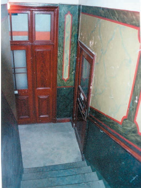
Trapphus med dörrblad 101 samt 109 (t v). 2004.
