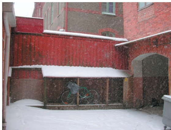
Träställning med plåttak för förvaring av gasflaskor. 2004
