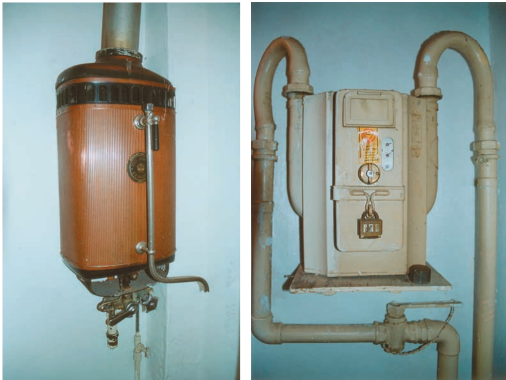
Rum 214: En äldre modell varmvattenberedare samt en gasmätare för poletter. 2004
