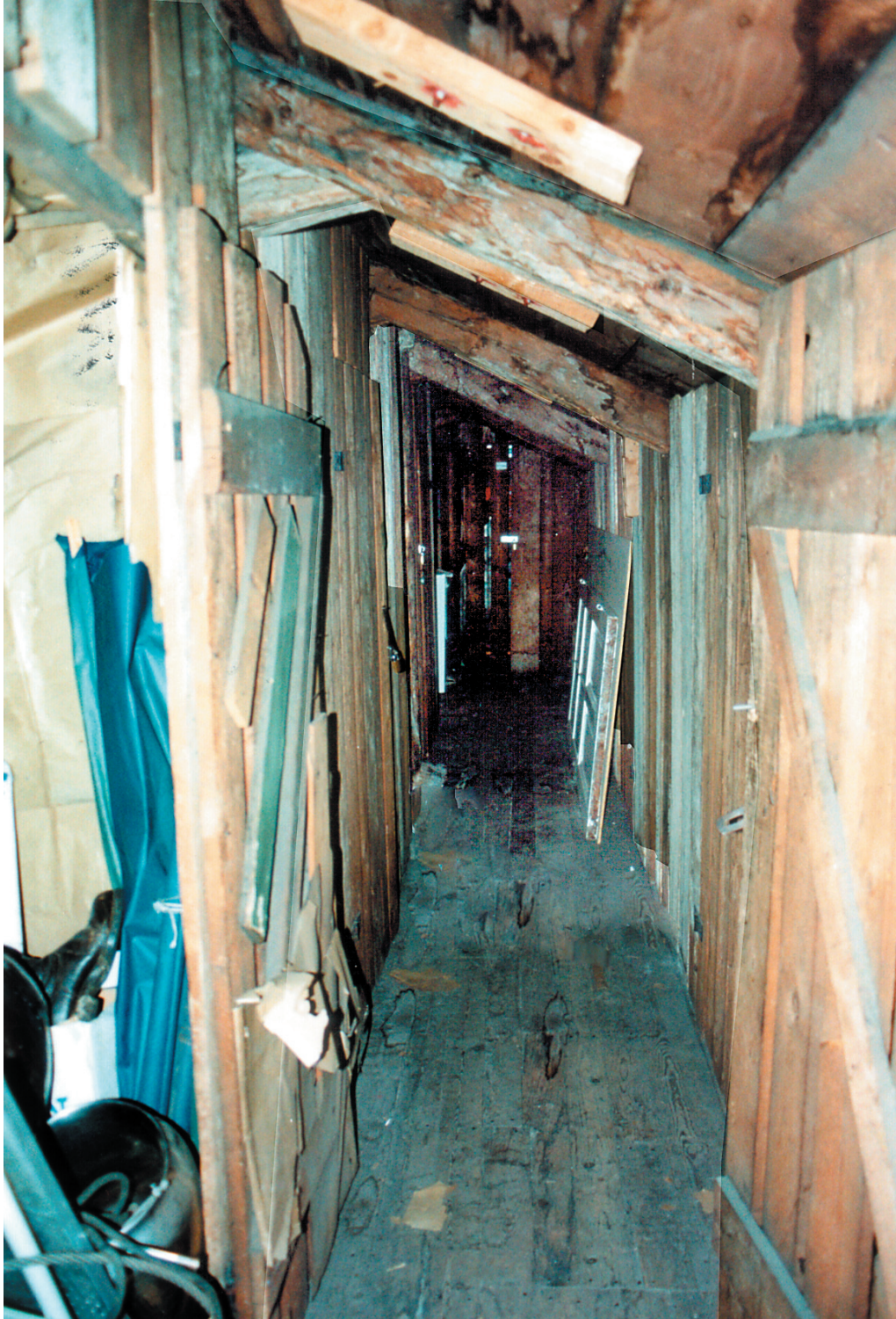
Den välbevarade vinde med träförråd utmed sidorna. 2004.
