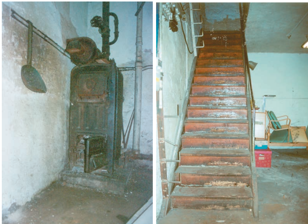
Rum 010. Äldre gjutjärnskamin samt trätrappa. 2004.
