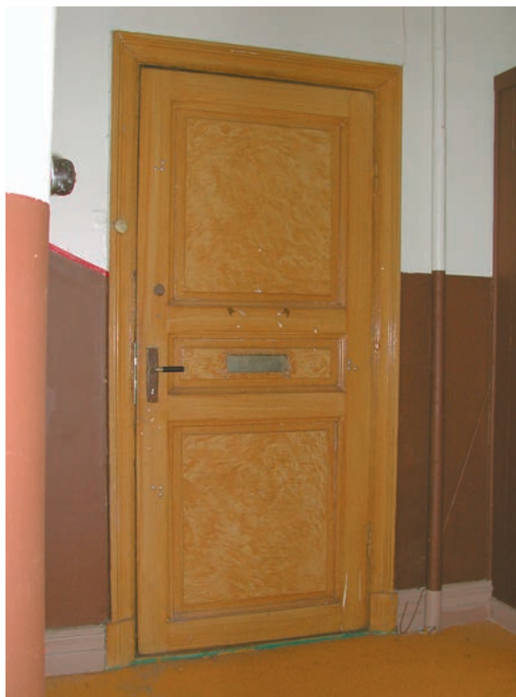
Ådringsmålad lägenhetsdörr i köktrappan. 2004.
