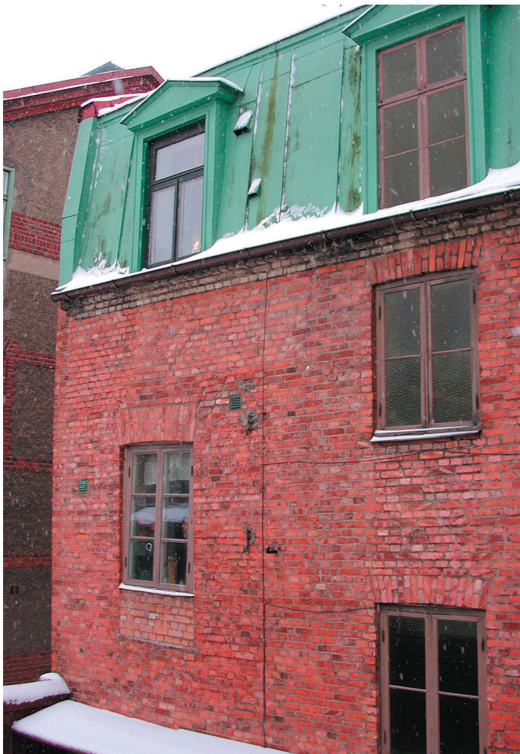
Del av gårdsfasaden, där vi t v ser att fönsterpartiet blivit flyttat. T h i bild syns de äldre fönsterpartierna som finns i trapphuset. 2004.
