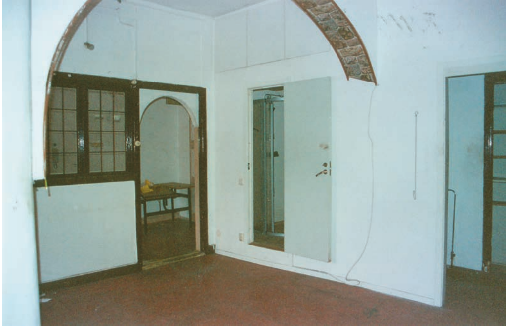
Rum 118 med valv, sett mot kök 115. 2004.
