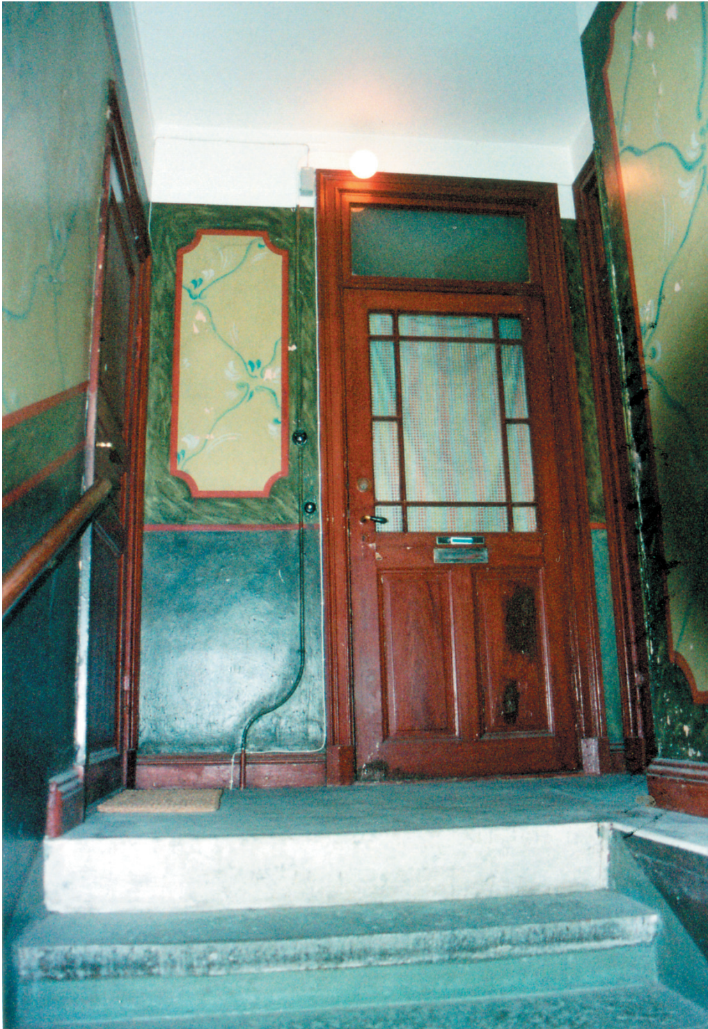
Trapphuset på Fjärde Långgatan 9 med bevarad dekorationsmålning. 2004.
