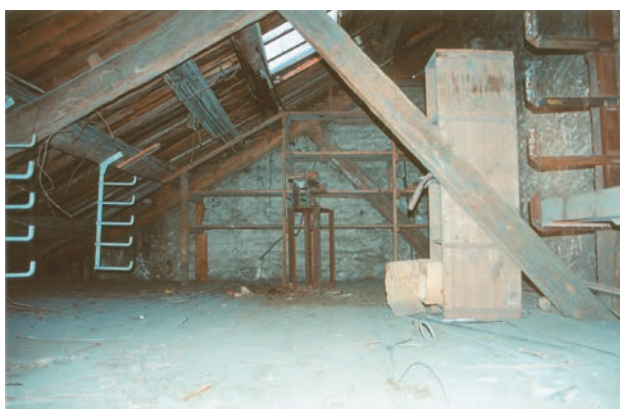
Ovan: Den gamla torkvinden med synliga bjälkar i takkonstruktionen. 2004. Nedan: Vindslokalen som ligger ovan lokal 3 och som används som förråd för verkstaden.
