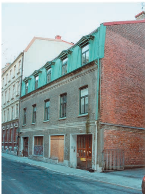
Gatufasad samt del av gavelfasad. 2004.
